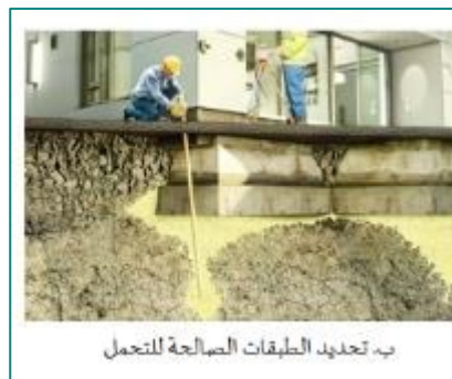
الشكل (2): خطوات حقن التربة بالأسمنت
