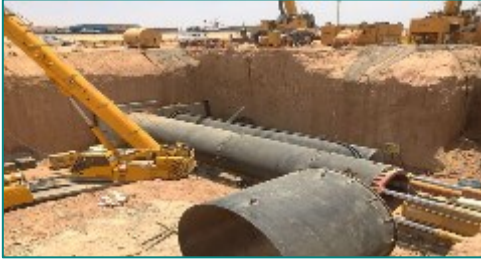
دفع المواسير بالمكابس الهيدروليكية
