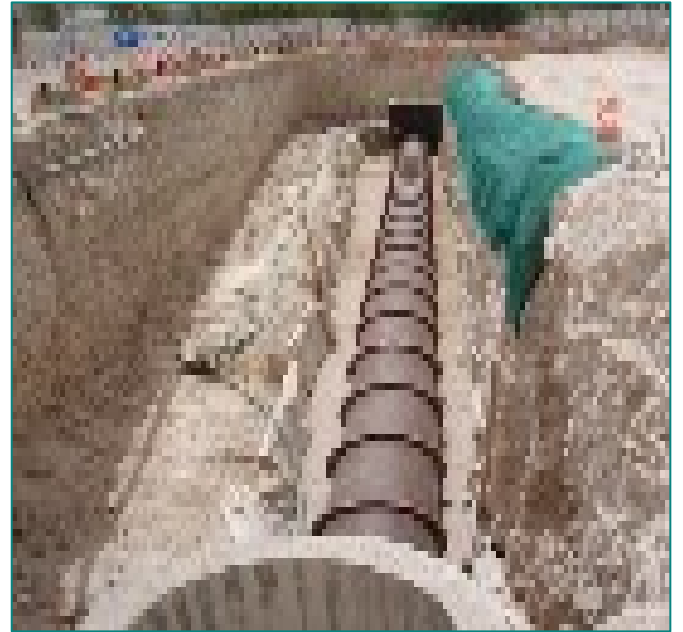
حالة تمديد مرفق وطبقة الحماية له في حفر مفتوح
