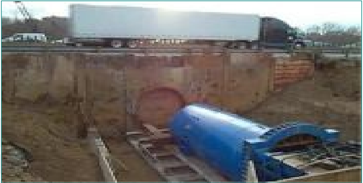
الشكل (9): وضع الاستعداد لحفر نفق بتقنية دفع المواسير
