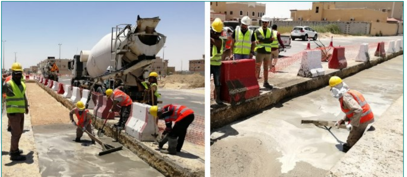
الشكل (4): تسوية طبقة (الخرسانة الرغوية)
