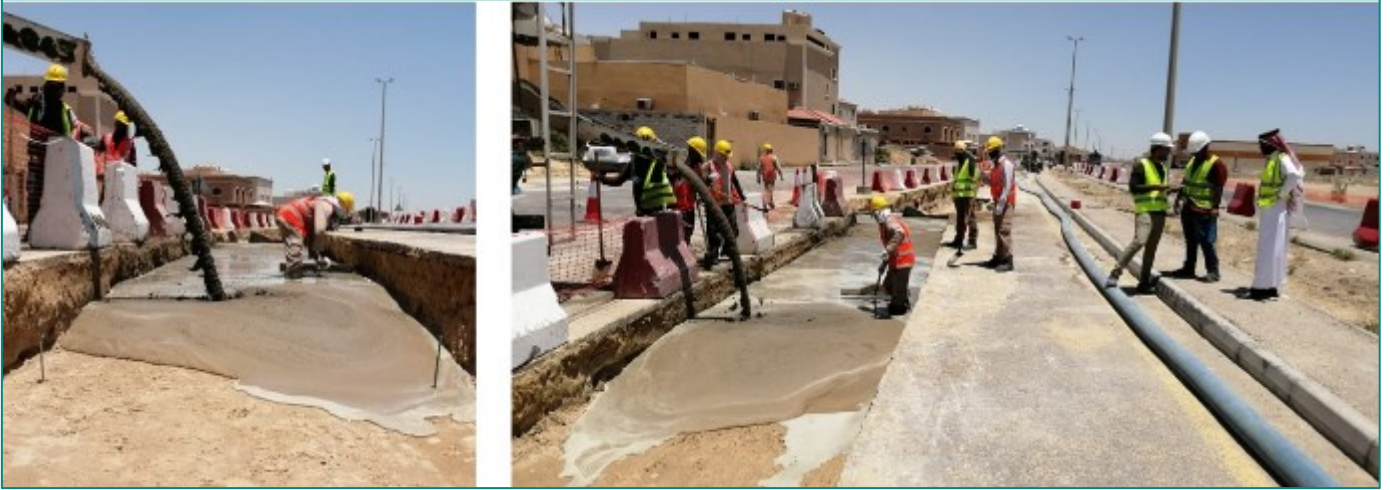
الشكل (3): وضع طبقة مواد (الخرسانة الرغوية)
